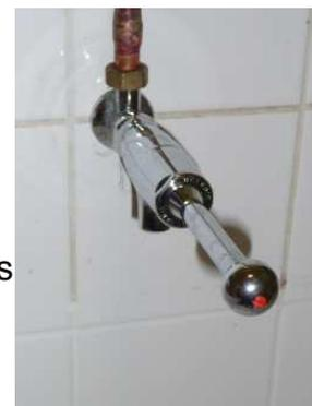
Les boutons "poussoir" ont été remplacés par un système à levier, plus facile à manœuvrer.
