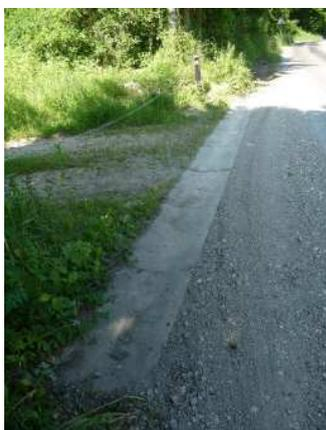
La pose d'un drain (diamètre 100) sur 45ml, la reconstitution du fossé sur 30ml, la mise en place d'un caniveau sur la largeur de l'accès et la finition en enduit de bitume sur 30m<sup>2</sup>,
