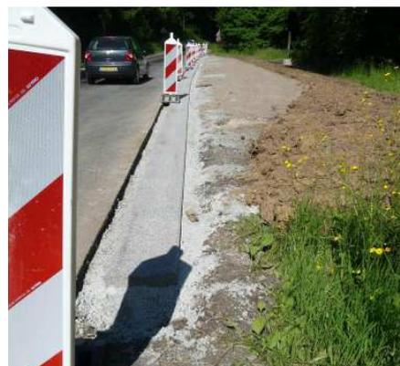
**Reprises de toutes les bordures de trottoirs fêlées, éclatées (joints au mortier de ciment), et remplacement pour les plus détériorées : de la Grand' Rue jusqu'à la rue de la Baroche : 5 010€ TTC.**
