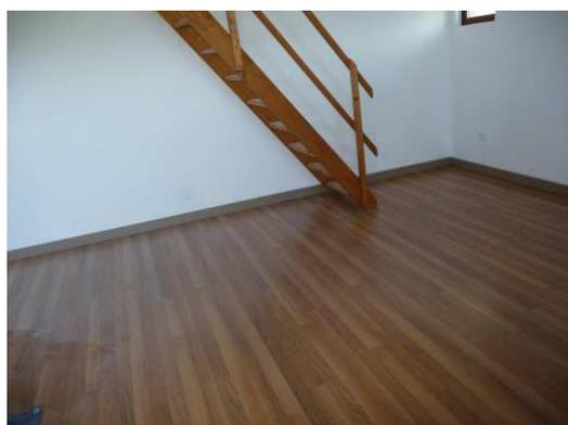
Le sol brut du garage n'étant pas plane (pente dans les 2 sens pour évacuation de l'eau au sol), un lambourrage et l'assemblage de panneaux OSB pour redressement du sol ont été prévus, ainsi que la pose d'un film polyane pour éviter les remontées d'humidité de la dalle. Il a été mis en place en finalité, un parquet flottant de qualité "grand passage".
