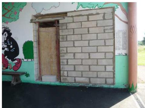
Suppression de la porte de garage, maçonnerie en agglo de 20 d'un mur + exécution d'un linteau et d'un seuil de porte, avec pour finition un enduit ciment sur la façade extérieure.
