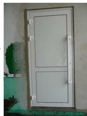
Mise en place d'une porte d'entrée sécurisée, aux normes "handicapés" d'un mètre de large, en aluminium isolé blanche,
