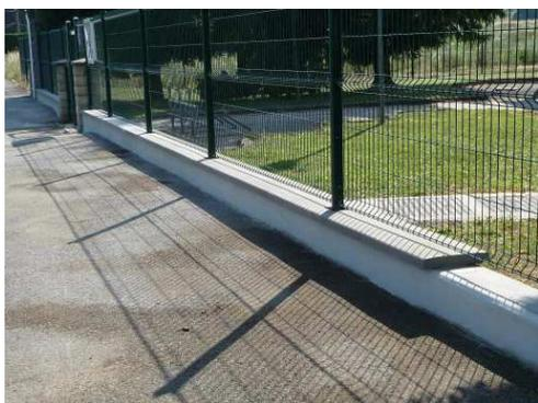
Ajout de couvertines afin de protéger murets et plaque béton (qui éclatent sous l'effet du gel en période hivernale) sur lesquels les grilles sont posées. Pour se faire, il a fallu recouper aussi toutes les clôtures (quelques centimètres).
