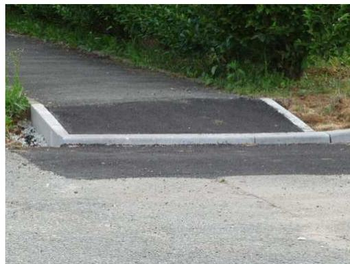
Fourniture et pose de bordures T2 en position basse (2cm), réfection des trottoirs en enrobés, remise à niveau des tampons existants implantés dans les secteurs de reprises.
