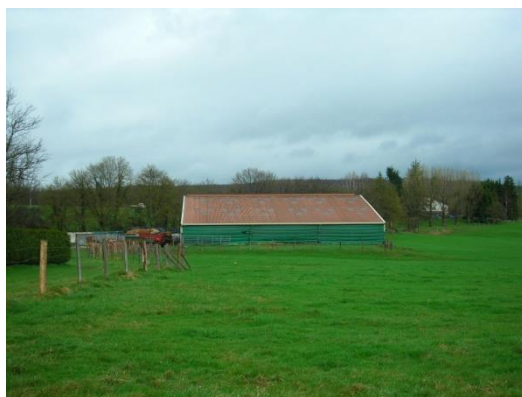
Exploitation au centre du village
