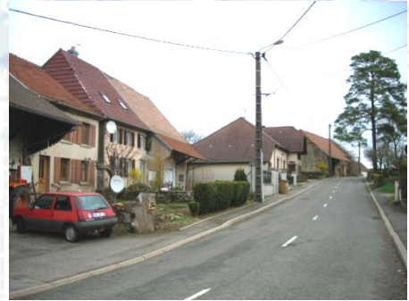
Exemple de densité dans le centre ancien
