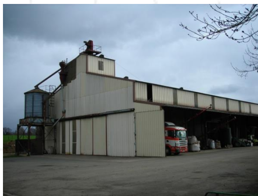
Bâtiments agricoles situés en plein cœur du village
